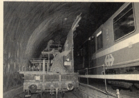
터널 보수 현장 Rosenberg Tunnel, Switzerland
