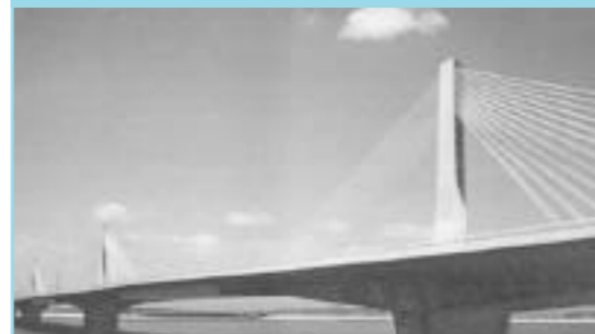
Kisogawa Bridge(木曾川橋, , 2000)
