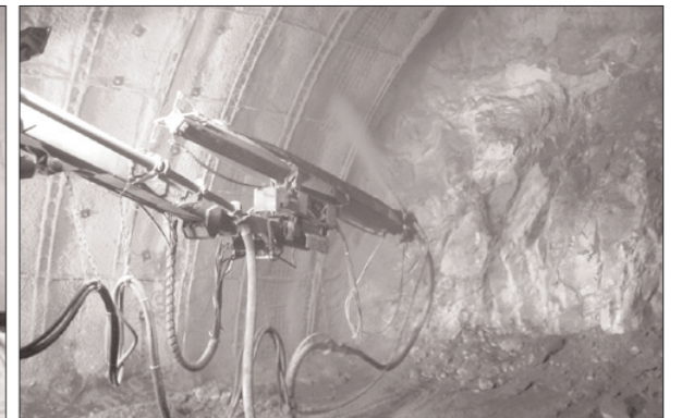
소양강 보조여수로 터널(A건설)
