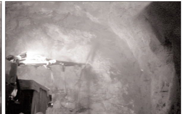
부산 신항만 배후철도 터널(A건설)
