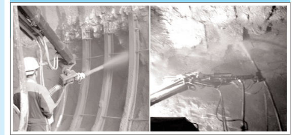
■ 그림 11. 측벽부 및 천정부의 여굴의 시공
