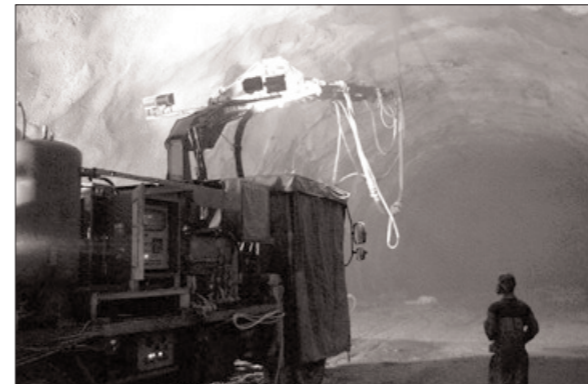
거가대교 접속도로 제2터널(B건설)
