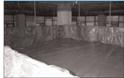
■ 그림 18. 변위계 설치 전경
