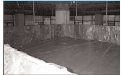
■ 그림 18. 변위계 설치 전경
