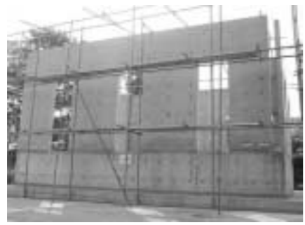
사진 1 | 노출콘크리트 MOCK-UP TEST
