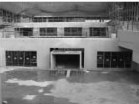
| 사진 4 | 노출콘크리트 시공현황(도서관 선칸)
