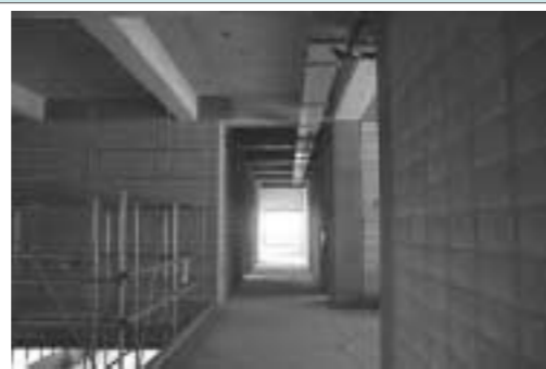
| 사진 5 | 강의동 내부 치장블럭공사 현황
