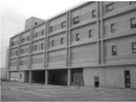
| 사진 3 | 노출콘크리트 시공현황(강의동 D동)
