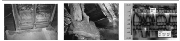
[그림 6] 커튼월의 내부구조 및 열손실 일례
