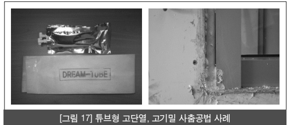
[그림 17] 튜브형 고단열, 고기밀 사춤공법 사례
