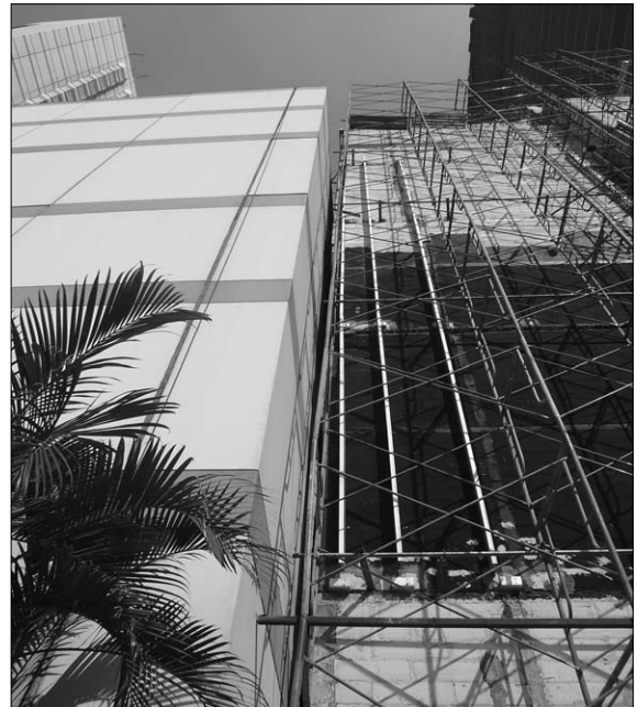
기존 건물과 증축건물 사이는 250mm 이격시키고 조인트 커버를 설치하기로 함. 두 개의 건물이 서로 연결되는 부분이 없을 경우에는 굳이 커버를 설치할 필요가 없음(시공 전)
