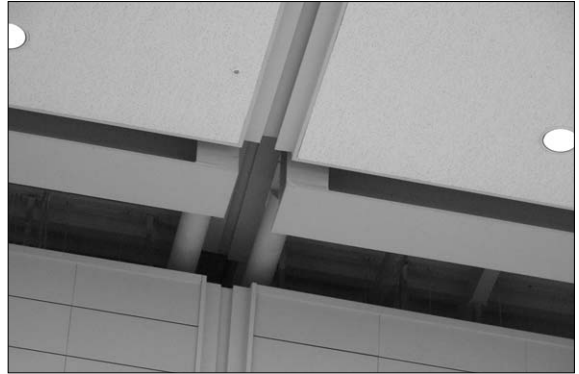
신축팽창에 대한 대응이 다른 곳에 비해 너무 적게 반영되어 주변의 돌이 밀리거나 파손이 발생됨.
