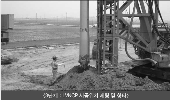
<3단계 : LVNCP 시공위치 세팅 및 항타>
