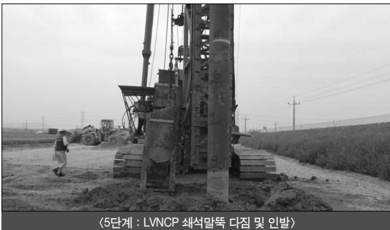
<5단계 : LVNCP 쇄석말뚝 다짐 및 인발>
