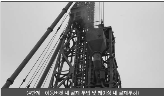
<4단계 : 이동버켓 내 골재 투입 및 케이싱 내 골재투하>
