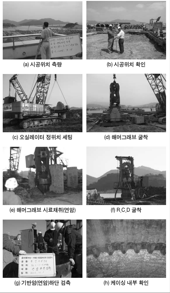
[그림 6-1] 현장타설말뚝 시공사진
