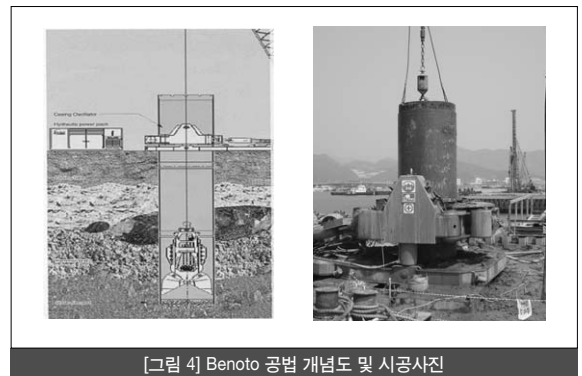
[그림 4] Benoto 공법 개념도 및 시공사진
