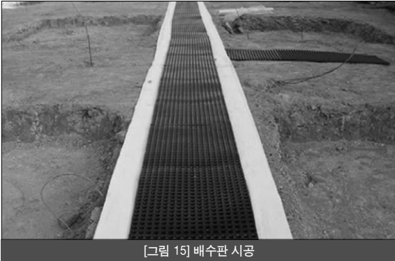
[그림 15] 배수판 시공
