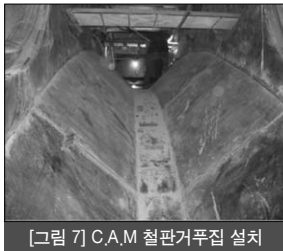
[그림 7] C.A.M 철판거푸집 설치
