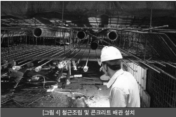
[그림 4] 철근조립 및 콘크리트 배관 설치
