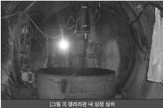
[그림 3] 갤러리관 내 심정 설치
