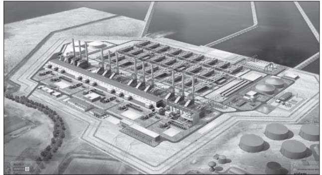
[그림 12] Marafiq Desalination Plant, KSA (佛 SIDEM-쌍용건설, 2008년~2009년 시공 중)
