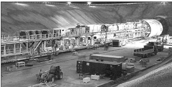
TBM공법의 경우는 디스크커터의 회전 압축력으로 굴착을 실시한 후 지보재 또는 콘크리트 라이닝을 설치하여 터널을 시공하는 방법으로서 특징적으로 여타의 공법에 비하여 굴진속도가 빠르며(평균 10m/일), 신선하고 균질한 보통암~경암층에 적합하다. 또한 원형단면으로 불필요한 공간의 발생을 최소화 할 수 있으며 단선병렬(직경 8m, 굴착단면적 : 50.26m<sup>2</sup>)과 복선터널(직경 11.5m, 굴착 단면적 : 103.87m<sup>2</sup>)로 나뉜다.
