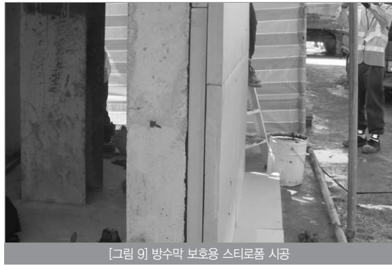
[그림 9] 방수막 보호용 스티로폼 시공
