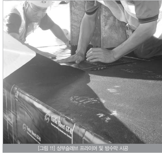
[그림 11] 상부슬래브 프라이머 및 방수막 시공
