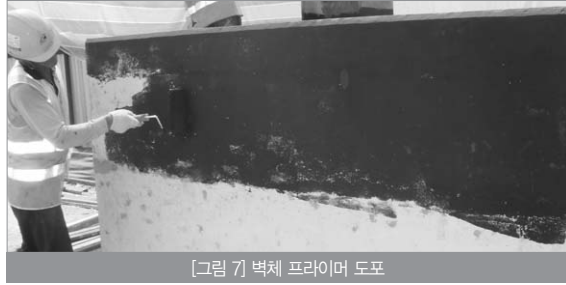
[그림 7] 벽체 프라이머 도포
