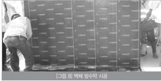
[그림 8] 벽체 방수막 시공
