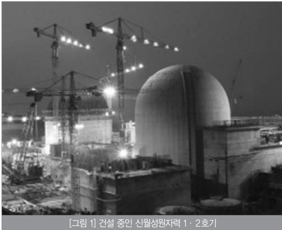
[그림 1] 건설 중인 신월성원자력 1·2호기
