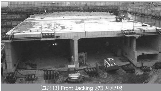
[그림 13] Front Jacking 공법 시공전경
