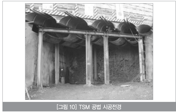
[그림 10] TSM 공법 시공전경
