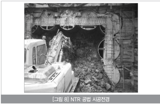
[그림 8] NTR 공법 시공전경
